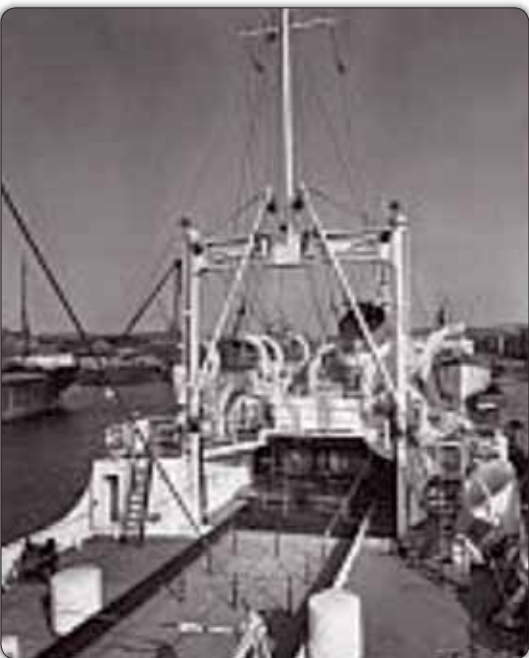
Myndin sýnir vinnuþilfarið. Ef rýnt er má sjá togvinduna sem sögð er 7 tonn, knúin tveimur rafmót- orum. Þó það komi ekki fram finnst mér líklegt að um splittvindur sé að ræða eða samtals 14 tonn. Spurning er hvort miðað sé við tóma tromlu, fulla tromlu eða eitthvað þar á milli. Rétt er að geta þess hér að skipið var með vélarúmið miðskips sem er í samræmi við hugmyndir Andrésar.
