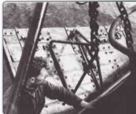
Þessi mynd er af hefðbundnum toghlerum þessa tíma. Myndin kemur fram í bókinni með fyrirögninni að þrátt fyrir allt hafi verið hægt að nota hefðbundinn toghlerum þótt togað hafi verið frá skut. Allt bendir til að nýju hlerarnir hafi ekki virkað sem skyldi þó það komi ekki beint fram í bókinni.
